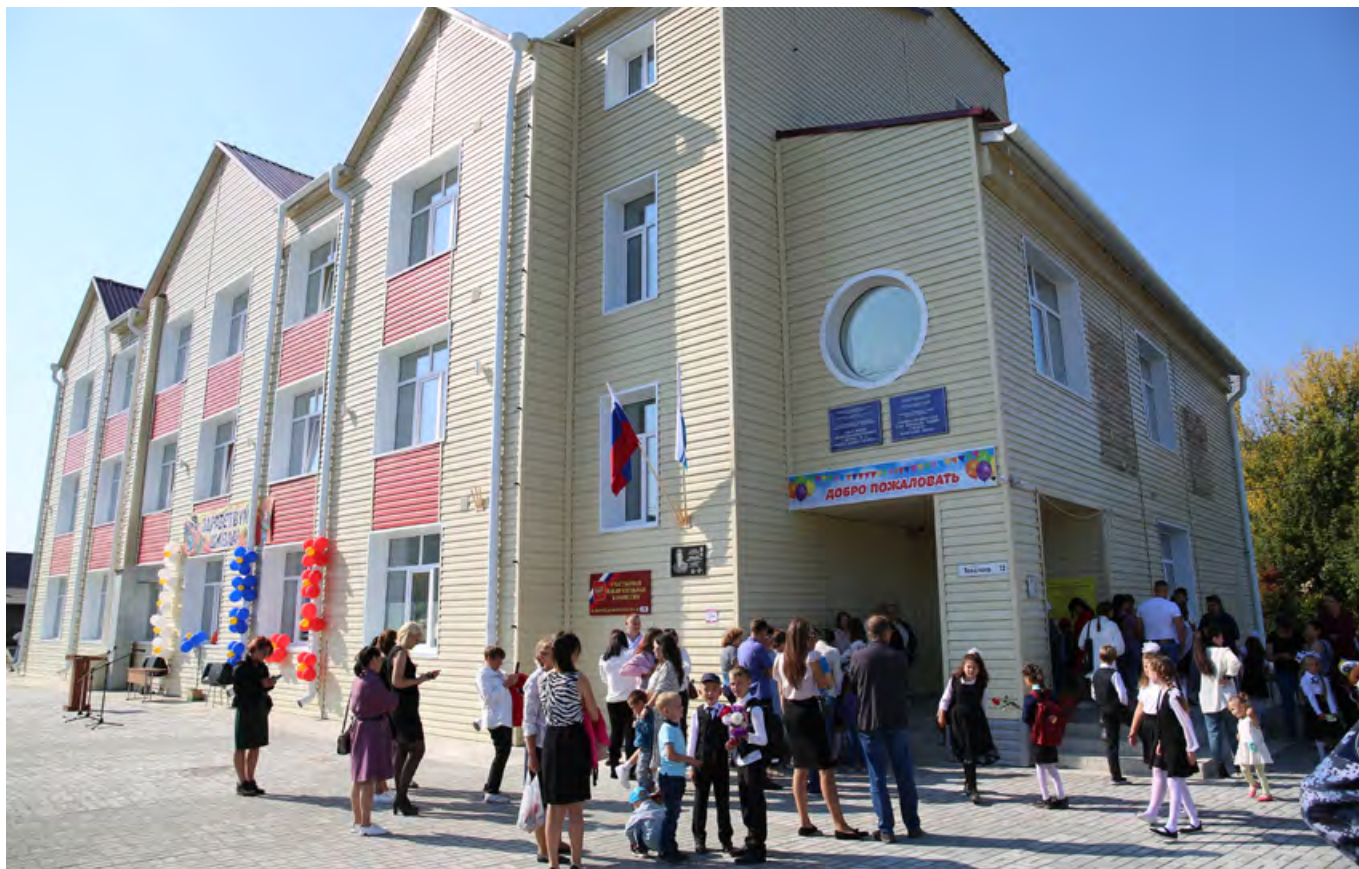
1 сентября 2022 г. в Горно-Алтайске после капитального ремонта открыли школу № 5
