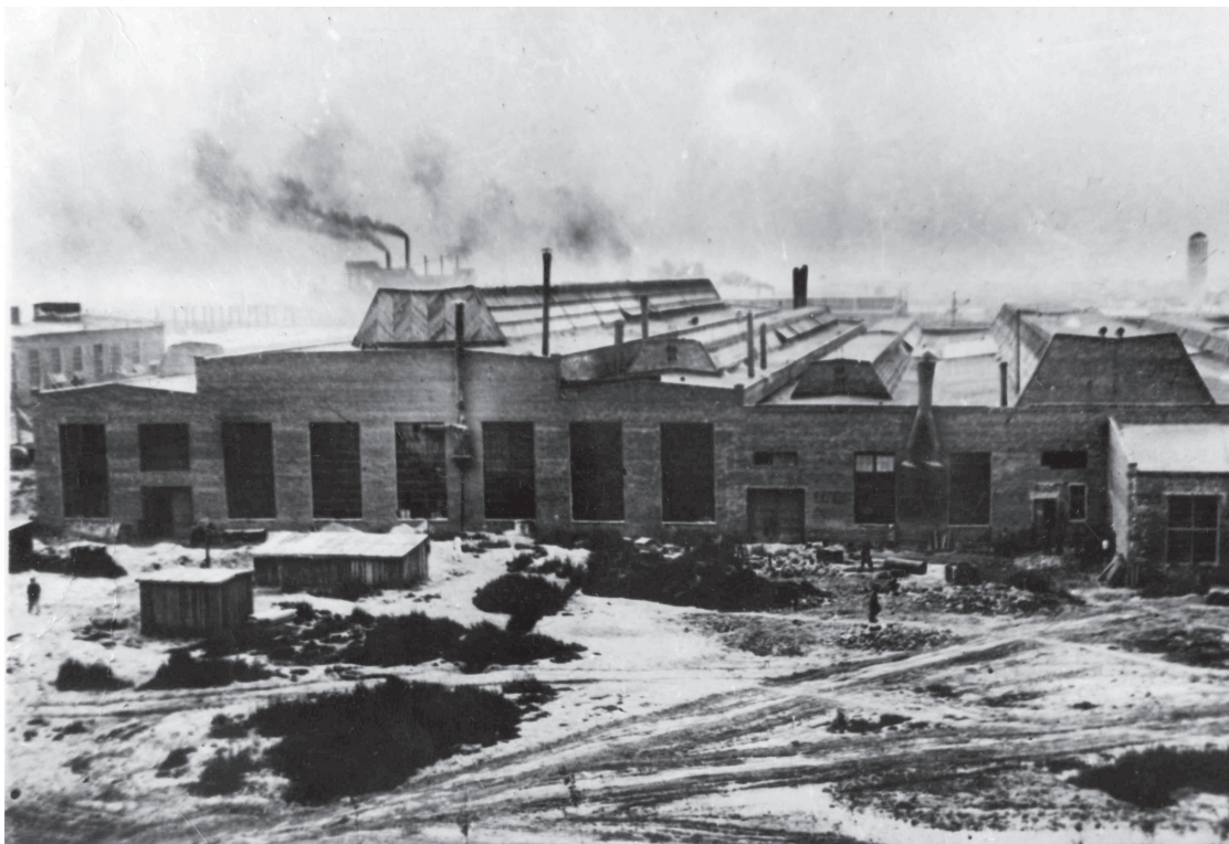
Строящиеся корпуса завода, зима 1942 г.
