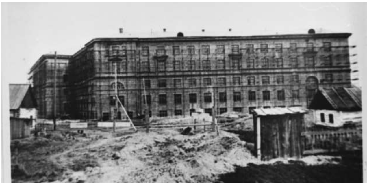
Фотография «Строительство главного корпуса Кемеровского горного института по ул. Весенней»» 1958 г.
