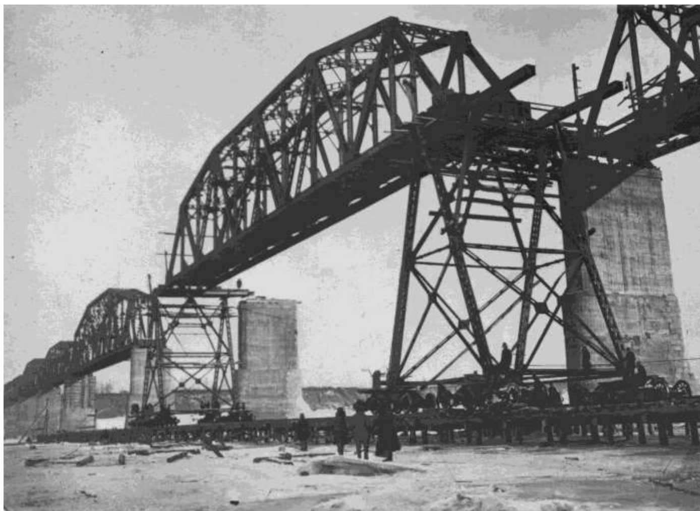
Фотография «Наводка фермы железнодорожного моста через р. Томь. Кемерово». 1933 г.
