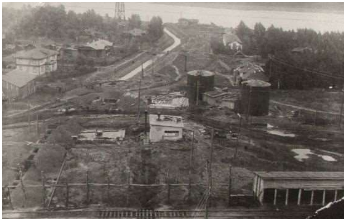
Фотография «Район Кемеровской ГРЭС». 1933 г.
