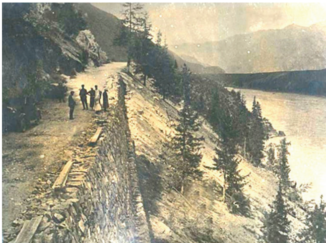
Каменная подпора, сооруженная на опасном участке дороги. Фотография 1934 г.
