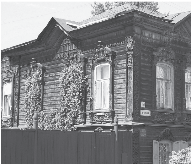
Дом В. М. Рыбакова в г. Бийске, ул. Толстого, 128.
