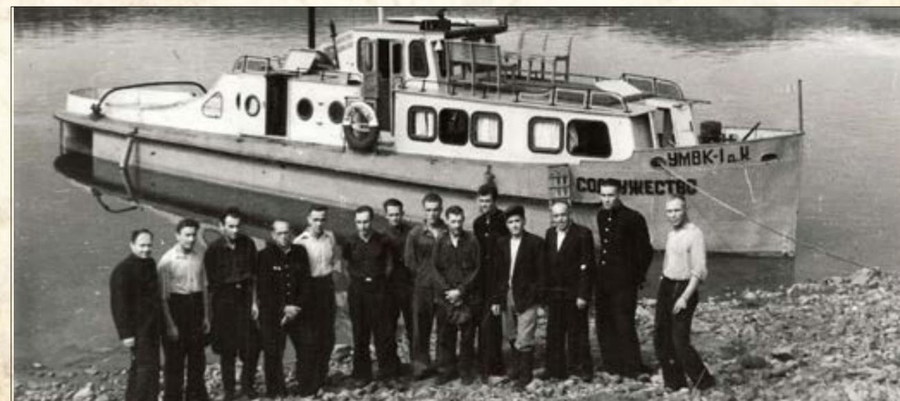
Инициаторы водометного судостроения в период испытания нового буксира типа УМВК-1аХ, освоенного серийным строительством в 1954 г., построено 67 единиц. КГКУ «ГАКК». Ф.П-7835. Оп.8. Д.126. Л.19
