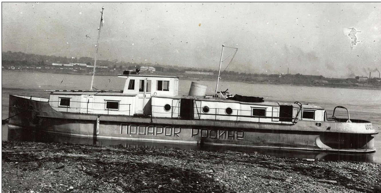
МБКХ-4 – первый водометный катер, положивший начало серийному строительству водометного флота на Красноярской судовой верфи, 1950 г. КГКУ «ГАКК». Ф.П-7835. Оп.8. Д.126. Л.17
