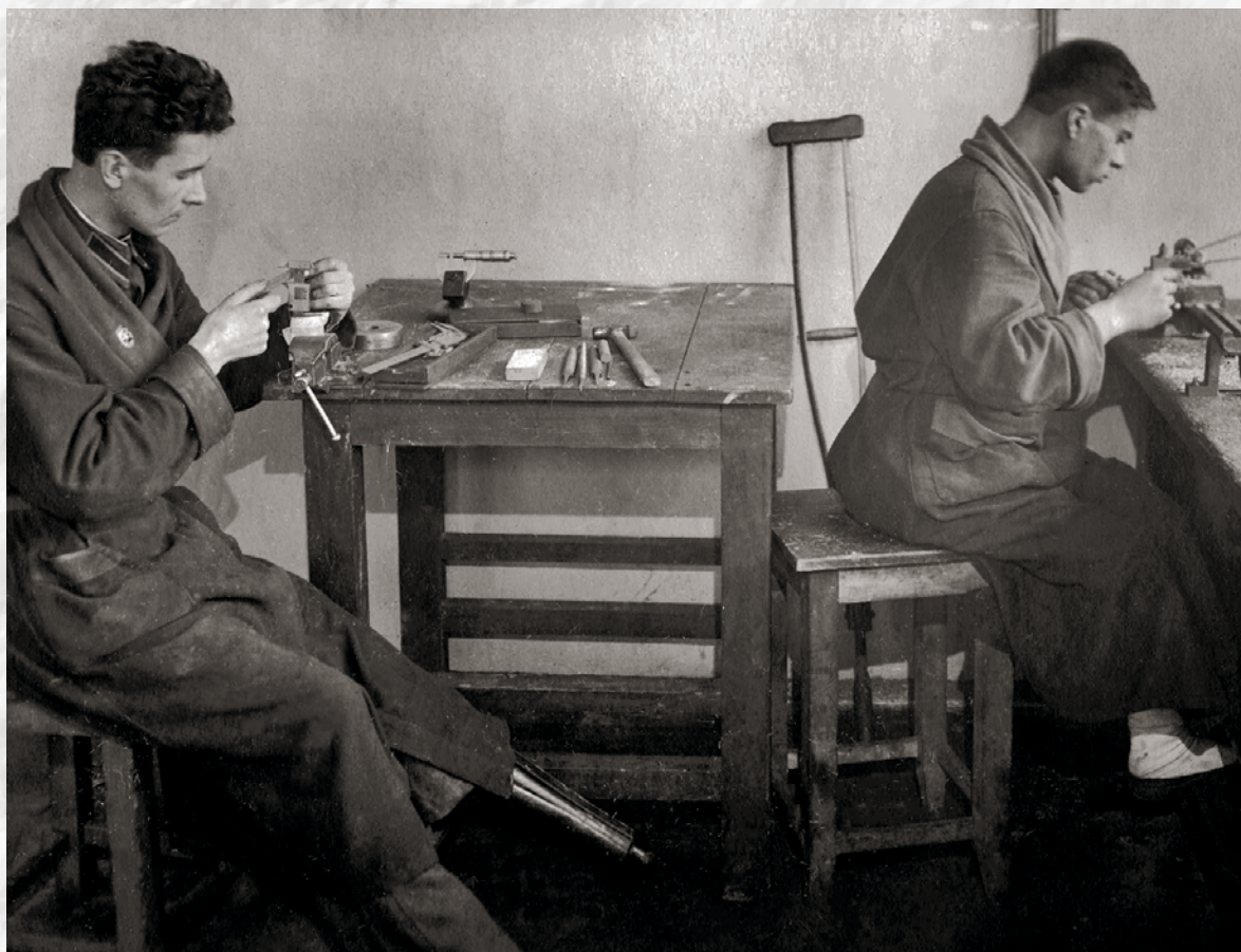
Раненый красноармеец П.И. Николаев (слева) за лекальной работой. Раненый красноармеец – токарь тов. Г.П. Козырьян (справа) обрабатывает точные детали на настольном токарном станке.
