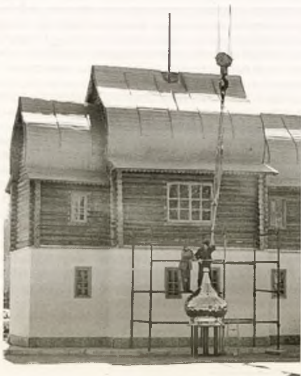
Установка купола на храме Архангела Михаила на Старо-Северном кладбище. 2005 г. Фото А. М. Лосунова
