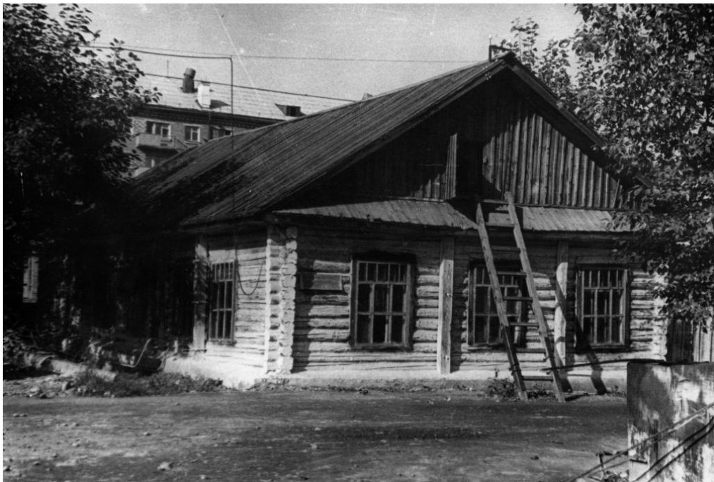
Деревянный ткацкий цех
